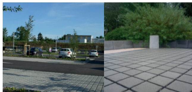
Places de parking en pavés drainants à joints gravillonnés
